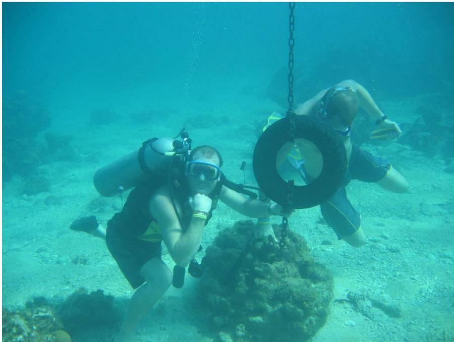
FOTOGRAFÍA 24. LA LLANTA USADA QUE SIRVE COMO AMORTIGUADOR YA INSTALADA EN LA CADENA
