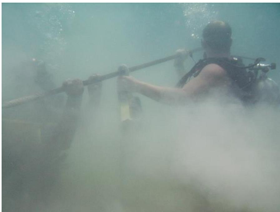
FOTOGRAFÍA 19. DOS BUZOS INSTALANDO TORNILLO DE ARENA
